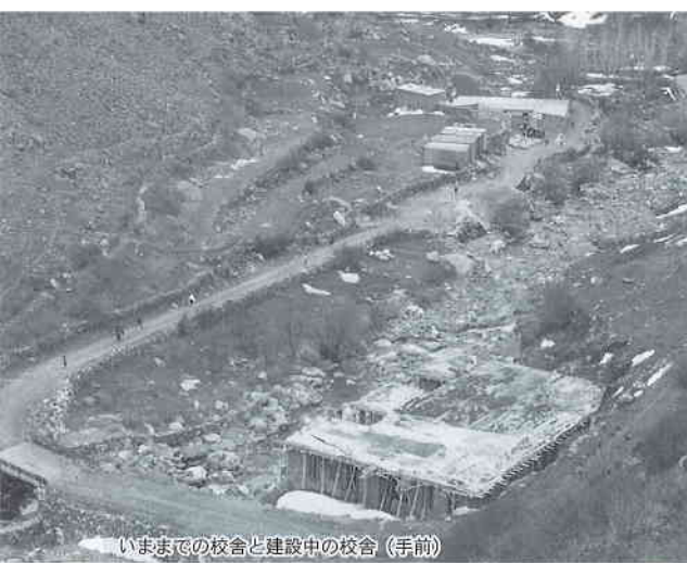
いままでの校舎と建設中の校舎(手前)
